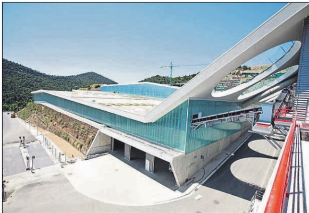
El vertedero controlado de Coll Cardús, en Vacarisses, ocupa 30 hectáreas
